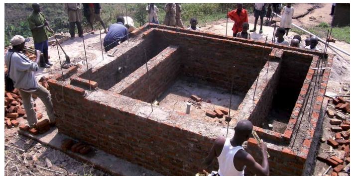
Decantador en fase de construcción
